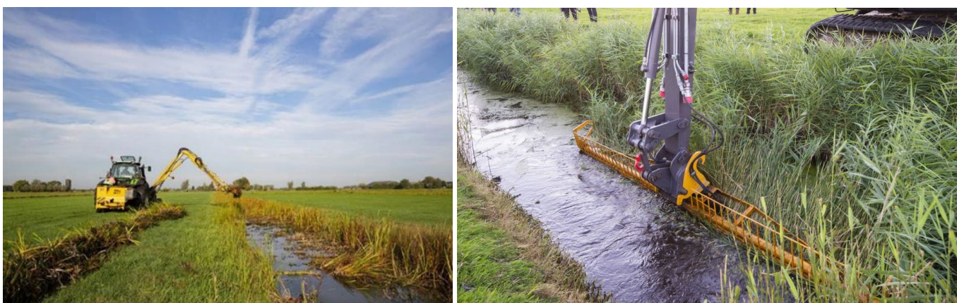
foto links: Vanuit het midden naar de trekker toewerken / foto rechts: vanaf de overzijde beginnen en 0,5 meter voor talud omhooghalen.
