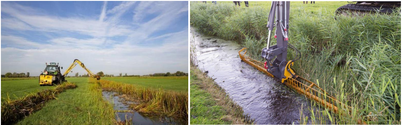
foto links: Vanuit het midden naar de trekker toewerken / foto rechts: vanaf de overzijde beginnen en 0,5 meter voor talud omhooghalen.
